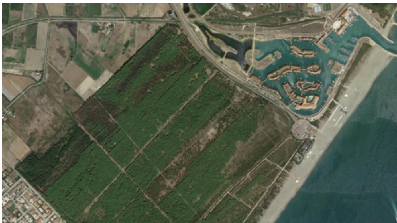
▲ Aspetti di degrado della Pineta litoranea per intrusione salina in corrispondenza di aree altamente antropizzate in località Torre Mozza comune di Policoro MT.
